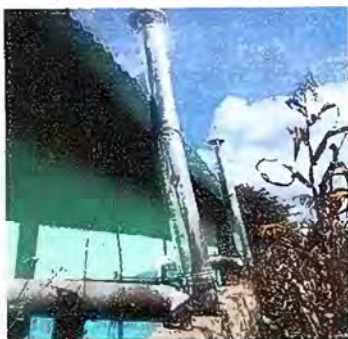
Foto 3Módulo 1: Sustitución de chimenea de metal
