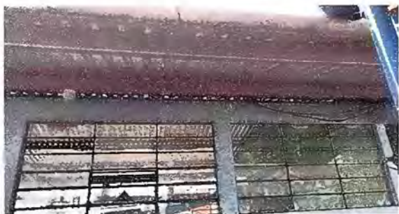
Foto 5 Módulo 2: Sustitución de canal de pvc
