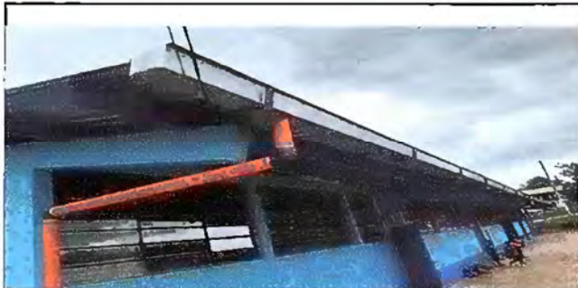
Foto 3: Modulo I, sustitucion de canales de pvc.
