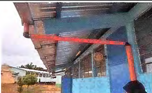
Foto 3: Modulo I, sustitucion de canales de pvc.
