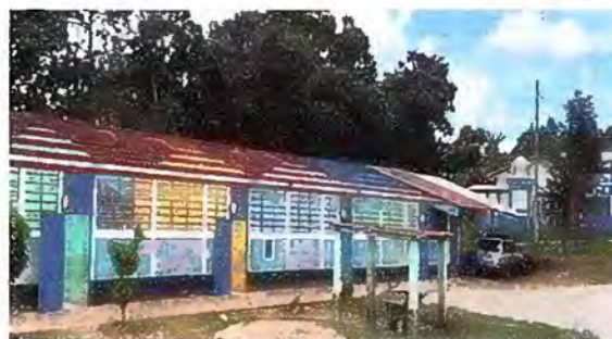
Foto : 2 modulos I, mantenimiento de estructura de soporte.
