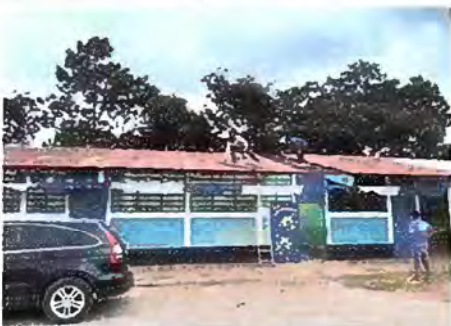
Foto1: modulos I, sustitucion de lamina por lamina aluzin calibre 26 y sustitucion de capote.
