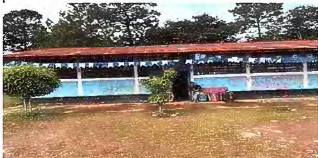
Foto1: modulo I, sustitucion de lamina por lamina aluzin calibre 26 y sustitucion de capote.
