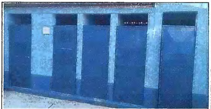
Foto 6: Modulo 3. Mantenimiento estructura de puertas
