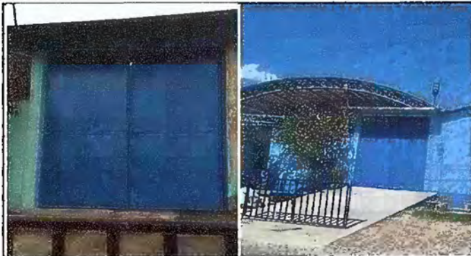
Foto 7: Muro Perimetral: Mantenimiento a portones de metal
