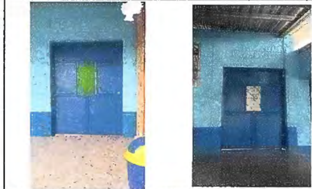
Foto 2: Modulo1. Mantenimiento estructura de puertas
