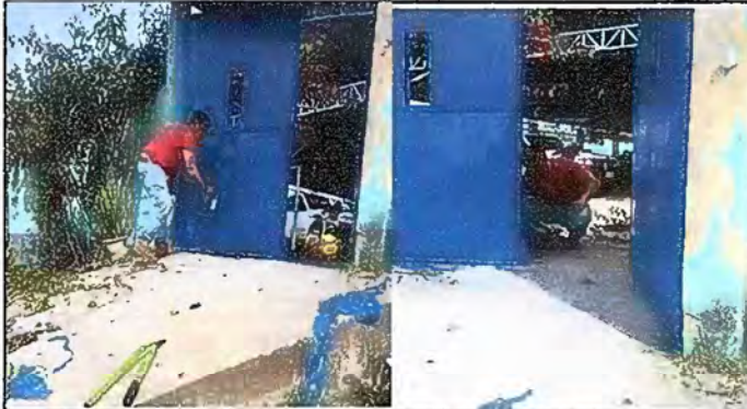
Foto7: Muro Perimetral: Mantenimiento a portones de metal
