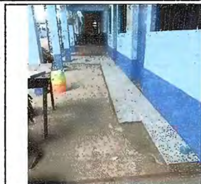
Foto 1: Modulo 1. Sustitución de piso de torta de concreto a piso de granito
