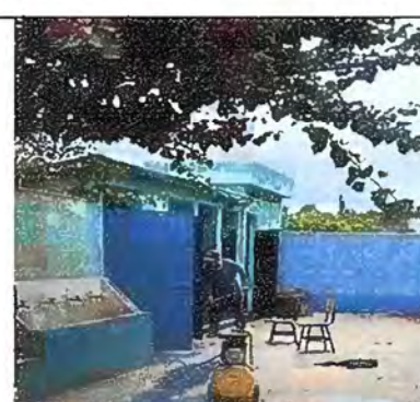
Foto 6: Modulo 3. Mantenimiento estructura de puertas
