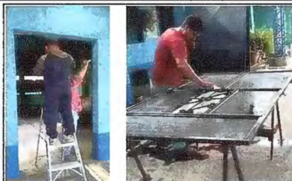
Foto 2: Modulo1. Mantenimiento estructura de puertas
