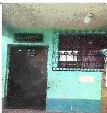
Foto 5: Módulo 2. Mantenimiento estructura de puertas
