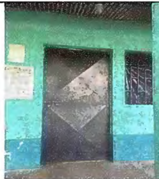
Foto 2: Módulo 1. Mantenimiento estructura de puertas
