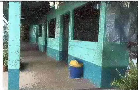
Foto 1: Módulo 1. Sustitución de piso de torta de concreto a piso de granito
