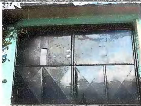
Foto 7: Muro Perimetral: Mantenimiento a portones de metal
