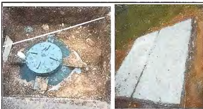
FOTO 24. AREA EXTERIOR: Sustitución de Biodigestor.
