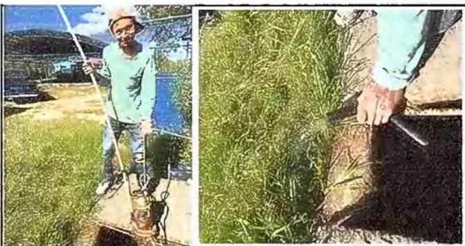
FOTO 23. AREA EXTERIOR: Sustitución de bomba de agua.
