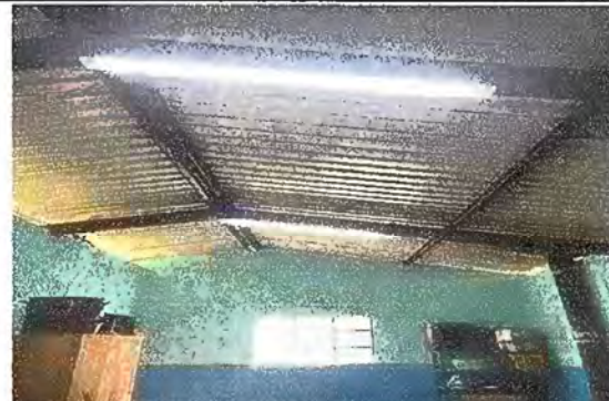
FOTO 4. MÓDULO 2: Sustitución de lámparas 2 x 40.
