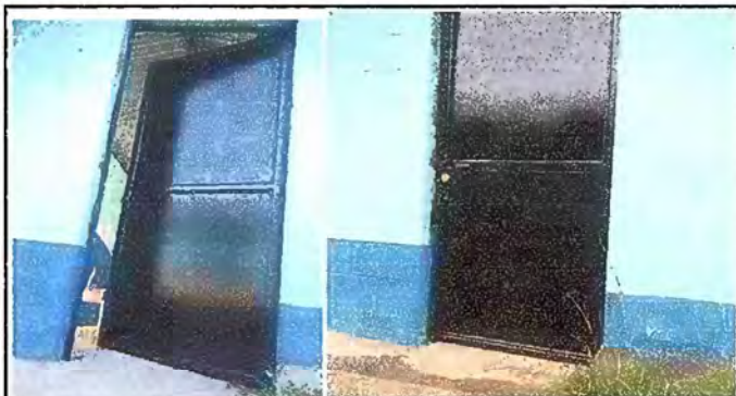
FOTO 8. MÓDULO 2: Mantenimiento a estructura de puerta (lijado, cambio de tubo, cepillado, sujeciones y aplicación de pintura). Reajuste de puerta.
