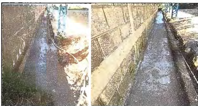
FOTO 12. MÓDULO 2: Reparación de cuneta de concreto.
