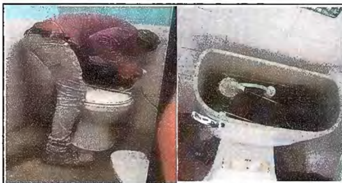
FOTO 5. MÓDULO 2: Sustitución de accesorios de inodoro (contra llave, tubo de abasto y tanque).
