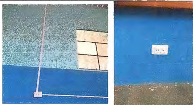
FOTO 3. MÓDULO 1: Sustitución de toma corrientes doble.
