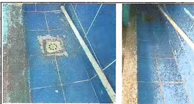
FOTO 6. MÓDULO 2: Sustitución de pisos y paredes.
