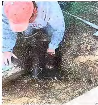
FOTO 25. AREA EXTERIOR Mantenimiento a caja de Registro.
