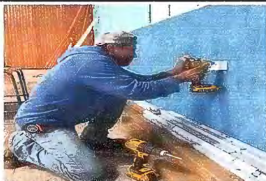
FOTO 17. MÓDULO 4: Sustrucción de tomacorrientes doble.
