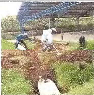
FOTO 26. AREA EXTERIOR. Cambio de cuneta por tubos de cemento.
