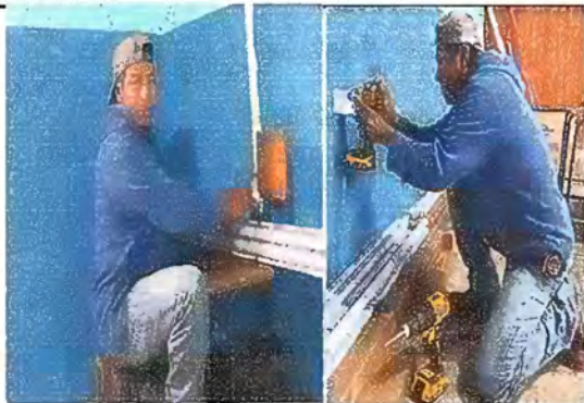
FOTO 7. MÓDULO 2: Reparación de cableado eléctrico.
