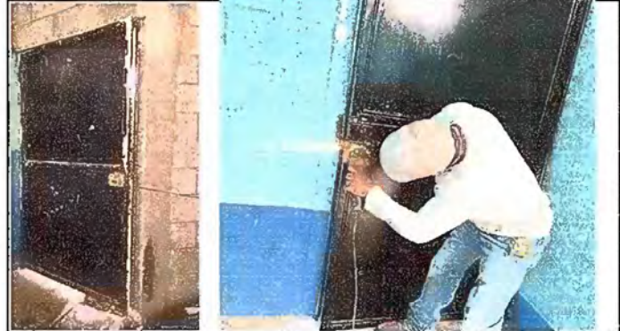
FOTO 20. MÓDULO 5: Mantenimiento a estructura de puerta (lijado, cambio de tubo, cepillado, sujeciones y aplicación de pintura). Reajuste de puerta.
