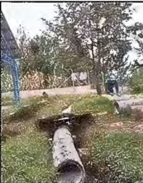
FOTO 26. AREA EXTERIOR. Cambio de cuneta por tubos de cemento.
