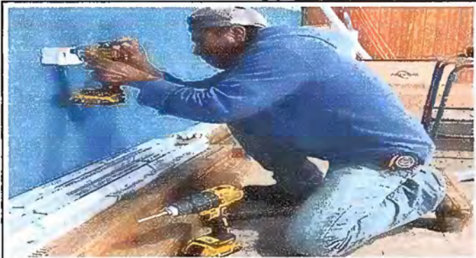
FOTO 3. MÓDULO 1: Sustitución de toma corrientes doble.
