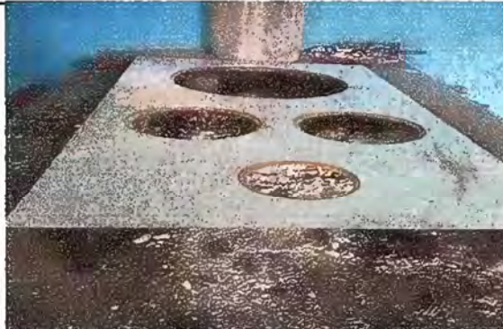
FOTO 10. MÓDULO 2: Sustitución de plancha de metal de 3 hornillas.
