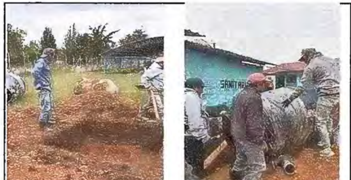
FOTO 24. AREA EXTERIOR: Sustitución de Biodigestor.
