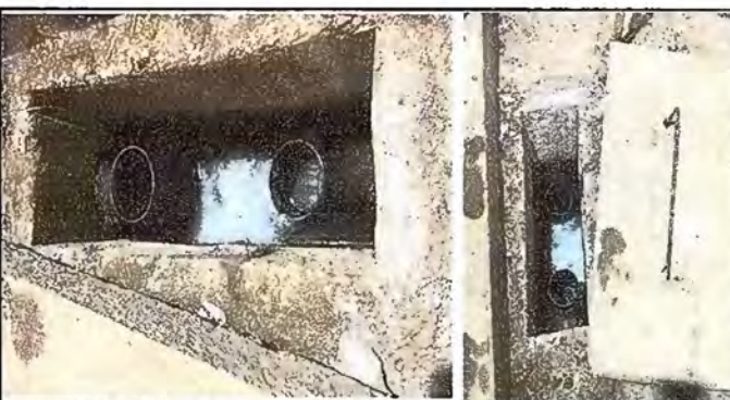
FOTO 24. AREA EXTERIOR Mantenimiento a caja de Registro.
