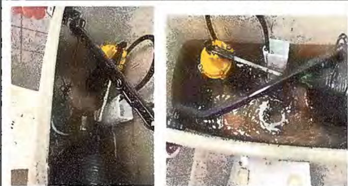
FOTO 21. MÓDULO 5: Sustrucción de accesorios de inodoro (contra llave, tubo de abasto y tanque)
