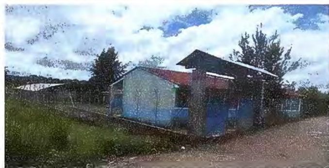
FOTO 25. PINTURA GENERAL. Pintura de muro interior y exterior.
