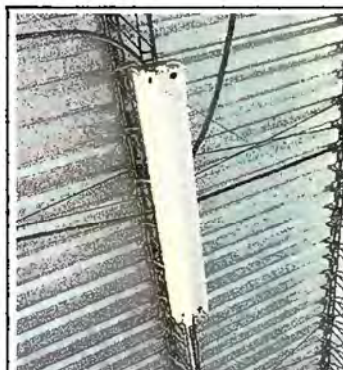
FOTO 15. MÓDULO 4: Sustitución de lámparas 2 x 40
