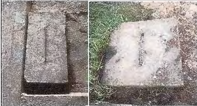
FOTO 25. AREA EXTERIOR Mantenimiento a caja de Registro.
