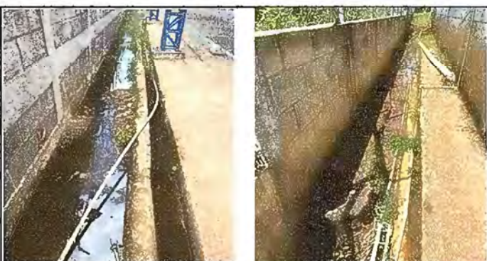
FOTO 12. MÓDULO 2: Reparación de cuneta de concreto.
