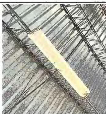
FOTO 15. MÓDULO 4: Sustitución de lámparas 2 x 40
