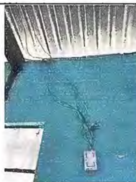
FOTO 16. MÓDULO 4: Sustitución de unidades de luz (incluye interruptor, ducto y cable eléctrico)
