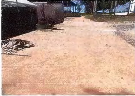
Foto 19: Patlo: Modulo 5 Reparación de piso de torta de concreto
