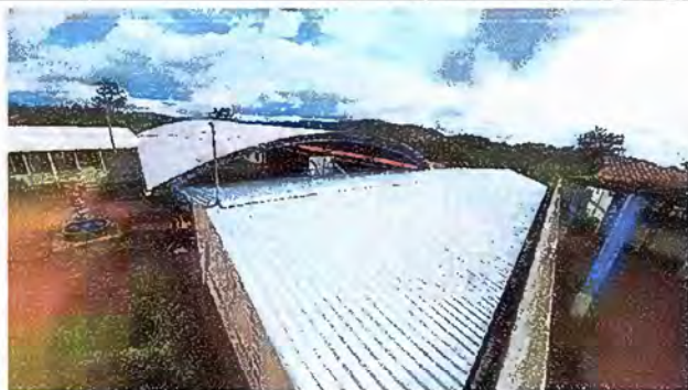
Foto 1: Modulo 1 Sustitución de lámina troquelada aluzinc calibre 26
