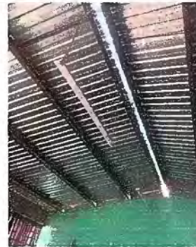
Foto 2: Modulo 1 Sustitución de capote de lámina para lámina troquelada, sustitución de elementos de fijación (tornillos).
