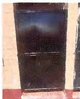
Foto 17: Modulo 5 Sustitución de puerta.
