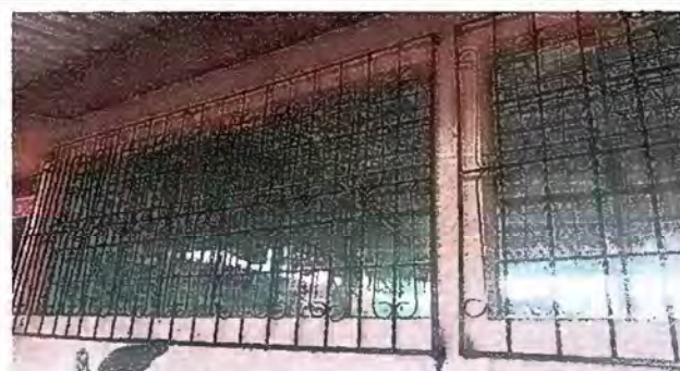
Foto 3: Modulo 1 Sustitución de balcón de metal.
