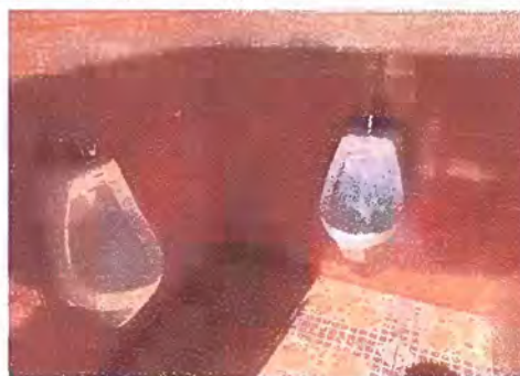
Foto 18: Modulo 5 Sustitución de mingitorio
