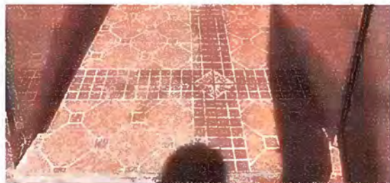
Foto 13: Modulo 5 Sustitución de Piso cerámico
