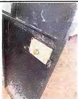
Foto 5: Módulo 1 Sustitución de Chapa
