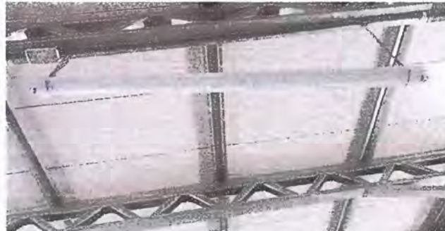
Foto 10: Modulo 3 Sustitución de lamparas 2x40
