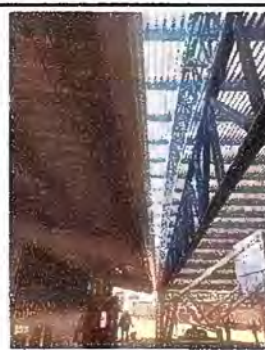
Foto 6: Modulo 1 Sustitución de Canal de pvc y Sustitución de soporte o pescante de metal para canal.
