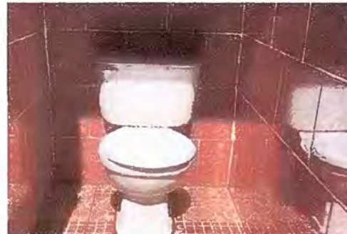
Foto 12: Modulo 5 Sustitución de accesorios inodoro(contra llave, tubo de abasto y tanque)
