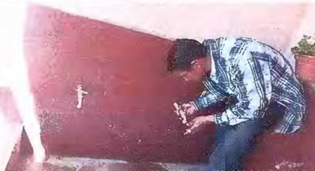
Foto 16: Modulo 5 Sustitución de grifos
