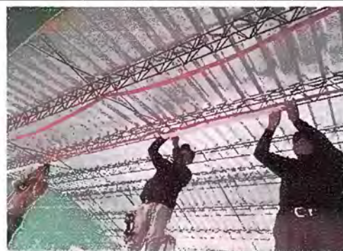
Foto 4: Modulo 1 Sustitución de lámparas 2x40, toma corrientes dobles, ducto electricos más accesorios.
