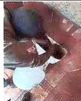
Foto 12: Modulo 5 Sustitución de accesorios inodoro(contra llave, tubo de abasto y tanque)
