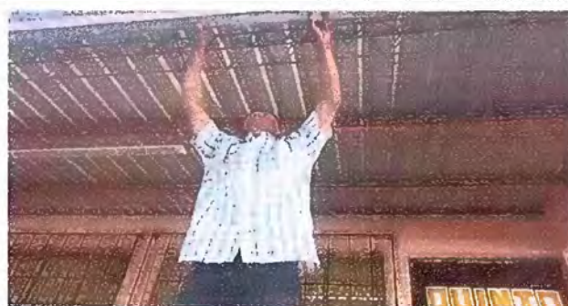
Foto 14: Modulo 5 Sustitución de Canal de PVC
