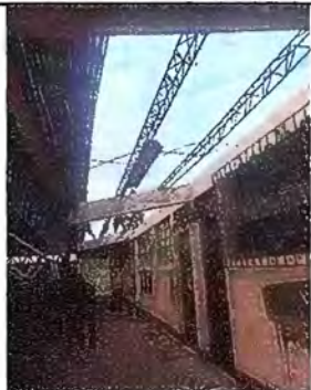
Foto 1: Modulo 1 Sustitución de lámina troquelada aluzinc calibre 26
