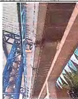
Foto 6: Modulo 1 Sustitución de Canal de pvc y Sustitución de soporte o pescante de metal para canal.
