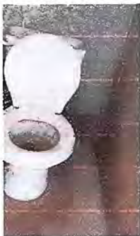
Foto 15: Modulo 5 Sustitución de tapadera de sanitario
