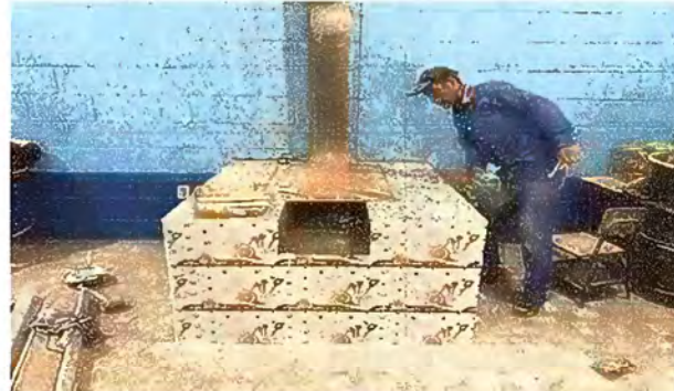
Foto2: MODULO 1. Sustitución de estufas rurales (completa) incluye chimenea y plancha de metal
