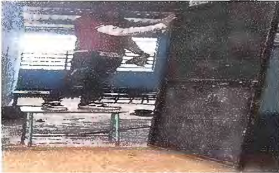
Foto 5: Modulo 3, mantenimiento de estructura de puerta (lijado, cambio de tubo, cepillado, sujeciones, aplicación de pintura) puertas de aula
