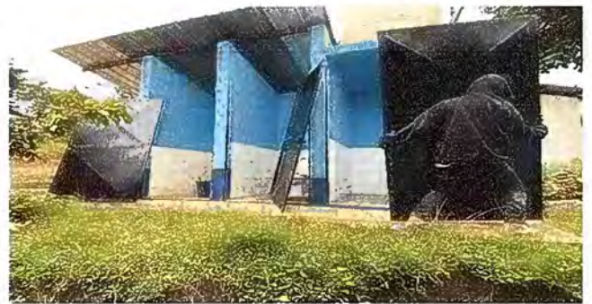
Foto 5: Modulo 3, mantenimiento de estructura de puerta (lijado, cambio de tubo, cepillado, sujeciones, aplicación de pintura) servicios sanitarios
