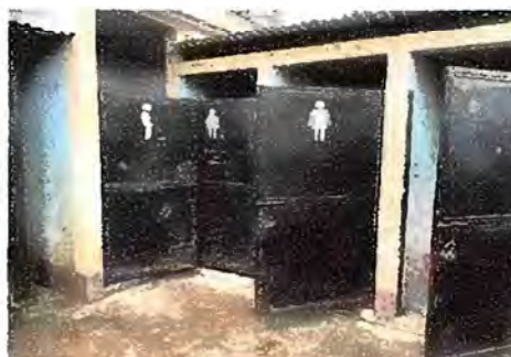
Foto 6: Modulo 2, mantenimiento de estructura de puerta (lijado, cambio de tubo, cepillado, sujeciones, aplicación de pintura) puertas servicios sanitarios
