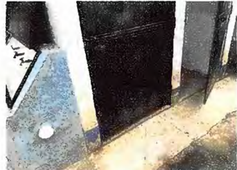
Foto 8: Modulo 3, mantenimiento de estructura de puerta (lijado, cambio de tubo, cepillado, sujeciones, aplicación de pintura) servicios sanitarios
