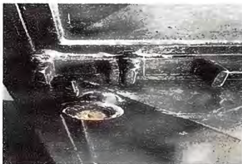
Foto 5: Modulo 2, mantenimiento de estructura de puerta (lijado, cambio de tubo, cepillado, sujeciones, aplicación de pintura) puertas de aula
