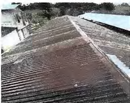
Foto 3: Modulo 2 Sustitución de lamina, por lamina troquelada aluzinc calibre 26
