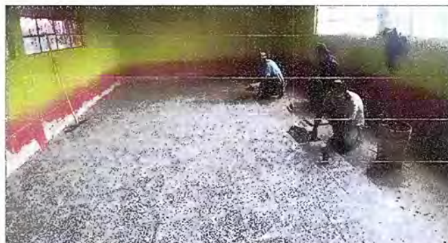
Foto 10: Esta foto es del Módulo 5 de sustitución de piso de torta de concreto de aula, PISO, fase de trabajo
