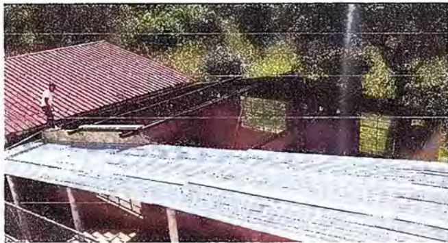
Foto 3: Esta foto es del Módulo 2 de sustitución de techado de la cocina, CUBIERTA DE LAMINA, fase de trabajo
