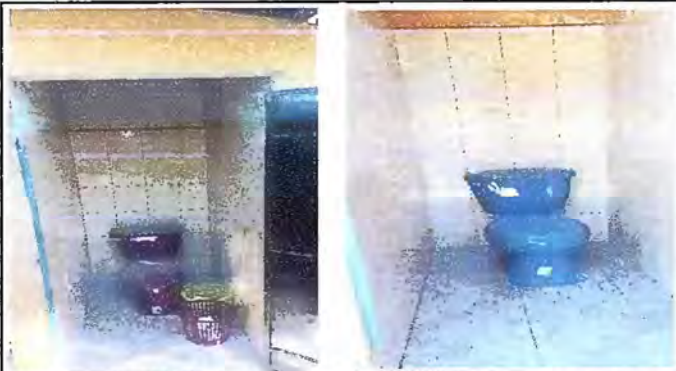
Foto 9: Sustitución de piso torta de cemento por cerámica y azulejo en baños, Módulo 6 y 7
