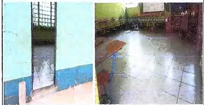
Foto 8: Sustitución de piso Torta de cemento por cerámica.
