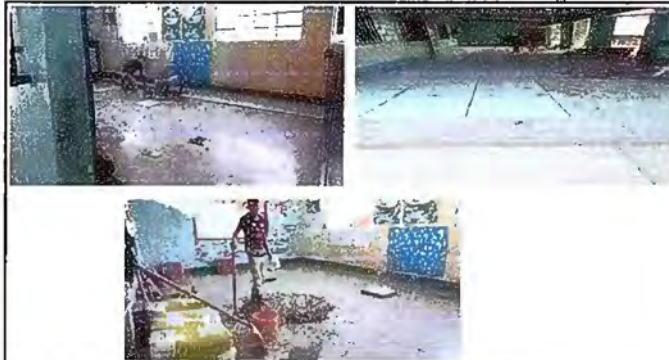
Foto 8: Susustitución de piso Torta de cemento por cerámica.
