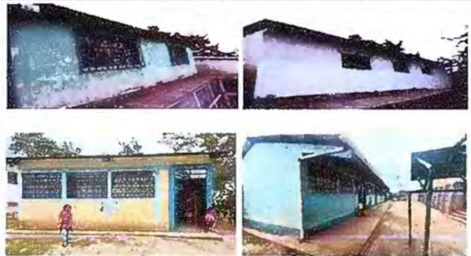
Foto 10: Pintura de pared interior y exterior.
