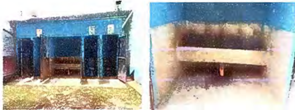
Foto 7: Modulo 7, Suministro e instalación de azulejo y sustitución de torta de cemento por cerámica.
