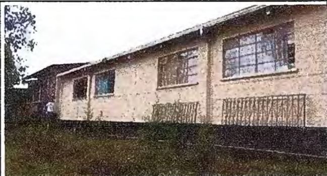
Foto 1: Módulo 1. Colocación de balcones y sustitución de canales de pvc por metal y pintura en paredes exteriores.
