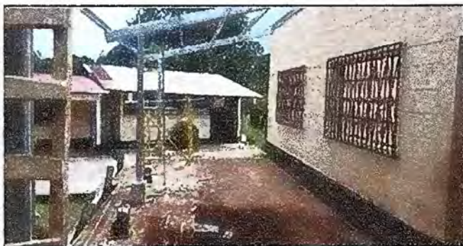
Foto 5: Módulo 2. Sustitución de estructura de soporte de madera por metal.
