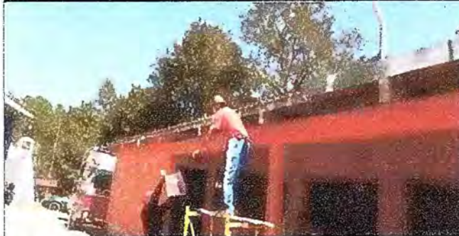
Foto 2: Módulo 1. Sustitución de canales de pvc por metal y pintura en paredes exteriores.
