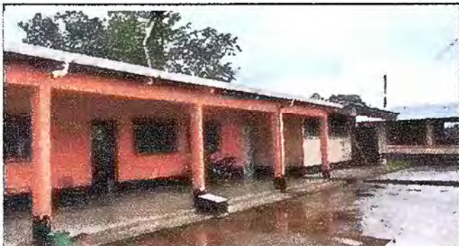
Foto 3: Módulo 1. Colocación de balcones en frente y atrás, pintura en paredes exteriores.
