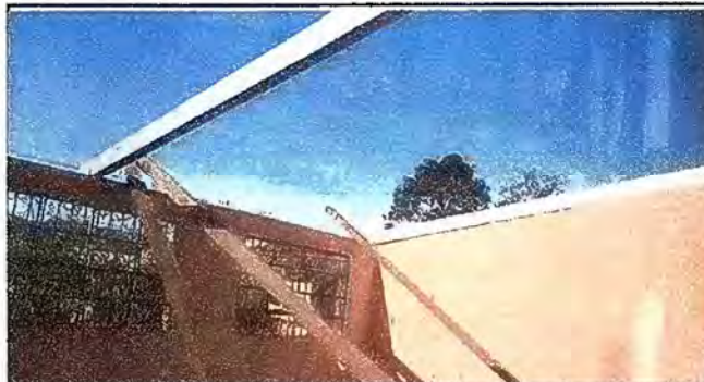
Foto 4: Módulo 2. Sustitución de estructura de soporte de madera por metal.
