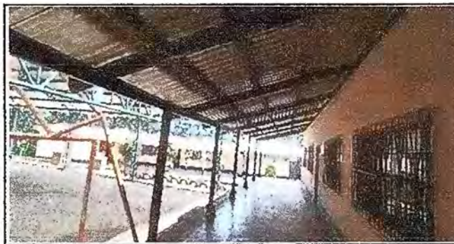
Foto 5: Modulo 2. Sustitucion de estructura de soporte de madera por metal.
