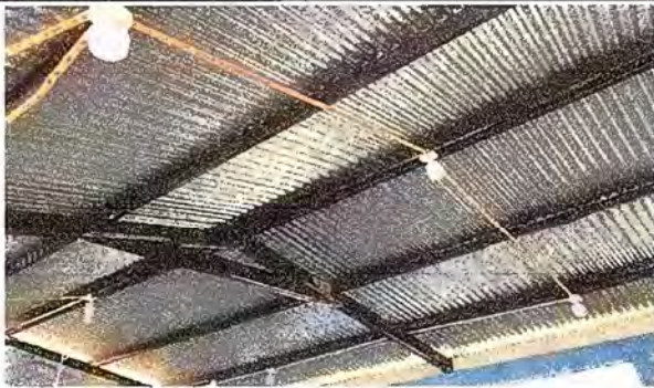
Foto 3. Módulo 2: Sustitución de focos ahorradores.
