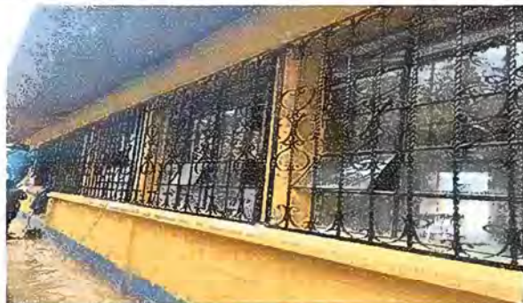
Foto1. Módulo 1: Suministro e instalación de balcón de metal.
