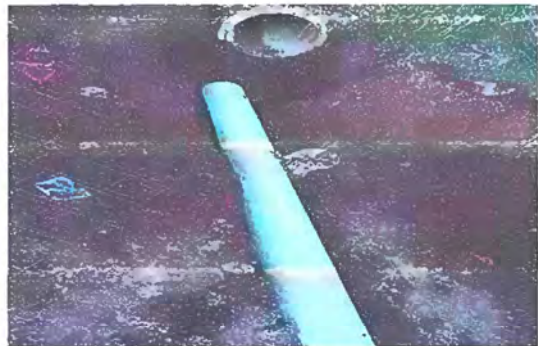
Foto1 PATIO: Sustitución de tubería PVC línea principal aguas pluviales
