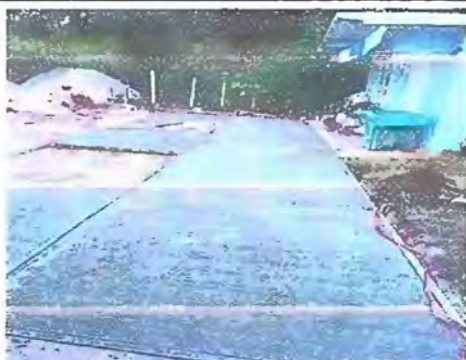
Foto 3 PATIO: Reparación de plancha de concreto patio
