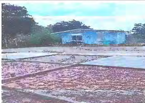
Foto 4 PATIO: Reparación de plancha de concreto patio
