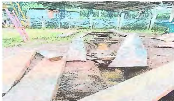
Foto1 PATIO: Sustitución de tubería PVC línea principal aguas pluviales
