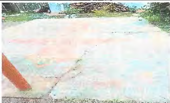
Foto 3 PATIO: Reparación de plancha de concreto patio
