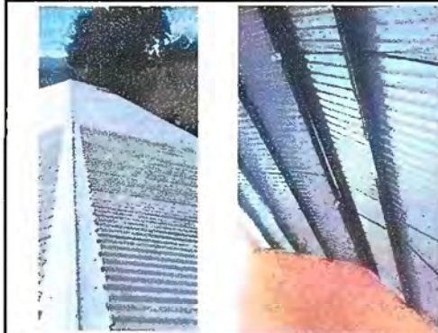
Modulo 1: sustitución de lámina por lámina troquelada, sustitución de capote, sustitución de canales, sustitución de pescante, sustitución de bajada de agua pluvial de PVC.
