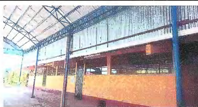
Modulo 1: Sustitucion de canales PVC, prescantes
