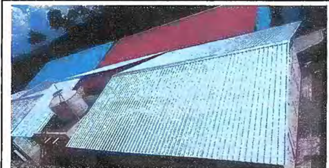
Modulo 2: Sustitucion de laminas por lamina troquelada, sustitución de capote.
