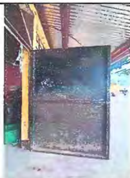
Foto 5: Mantenimiento a estructura de puerta lijado y pintado
