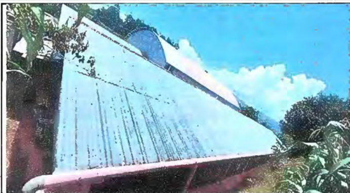
Modulo 1: sustitución de lámina por lámina troquelada, sustitución de capote, sustitución de canales, sustitución de pescante, sustitución de bajada de agua pluvial de PVC.
