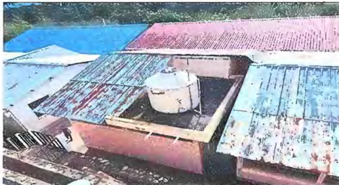
Foto 4: Sustitución de lámina troquelada, sustitución de capote, sustitución de canales, sustitución de pescante, sustitución de bajada de agua pluvial de PVC.
