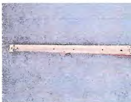
Foto 5 - MODULO 1: Sustitución de lámpara de 2 X 40
