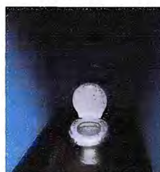
Foto 24 - MODULO 3: Sustitución inodoro
