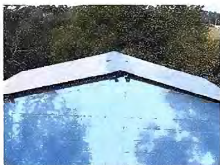
Foto 21 - MODULO 3: Sustitución de capote de lámina para lámina troquelada
