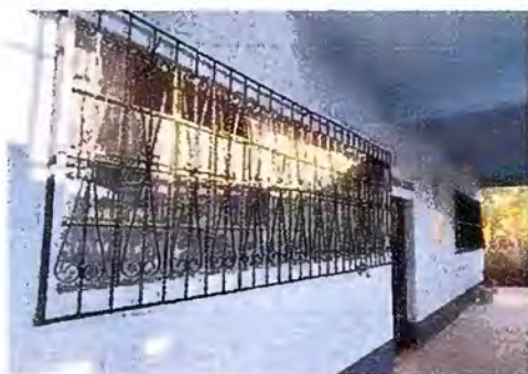
Foto 3 - MODULO 1: Mantenimiento a balcones de metal
