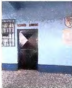
Foto 1 - MODULO 1: Mantenimiento a estructura de puerta
