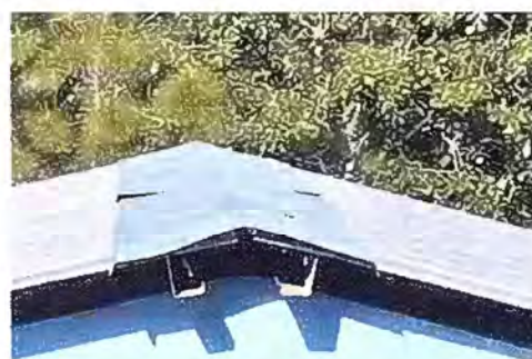
Foto 22 - MODULO 3: Sustitución de elementos de fijación (tornillos)
