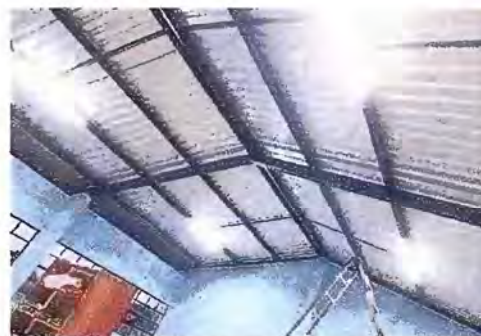
Foto 16 - MODULO 1: Reparación de cableado eléctrico
