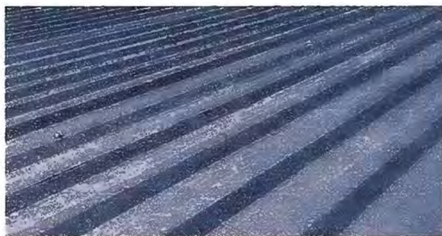
Foto 9 - MODULO 1: Sustrución de elementos de fijacion (tornillos)
