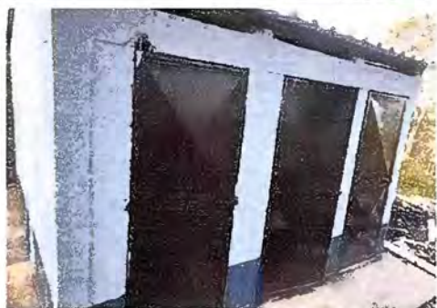
Foto 23 - MODULO 3: Mantenimiento a estructura de puerta
