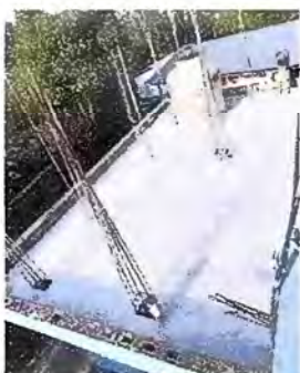
Foto 17 - MODULO 2: Impermeabilización de losa
