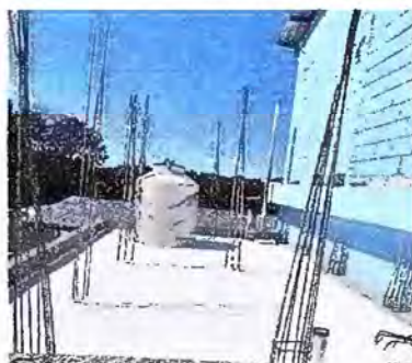
Foto 17 - MODULO 2: Impermeabilización de losa
