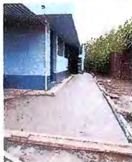
Foto 19 - MODULO 2: Reparación de banquetas de concreto
