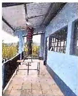
Foto 15 - MODULO 1: Sustitución de focos ahorradores
