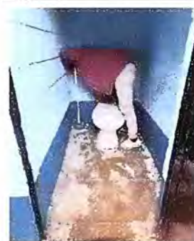
Foto 24 - MODULO 3: Sustitución inodoro
