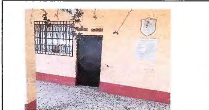
Foto 1 - MODULO 1: Mantenimiento a estructura de puerta
