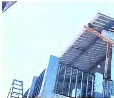
Foto 12 - MODULO 1: Sustrución de soporte o pescante de metal para canal
