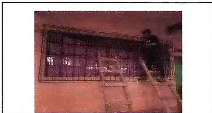
Foto 3 - MODULO 1: Mantenimiento a balcones de metal
