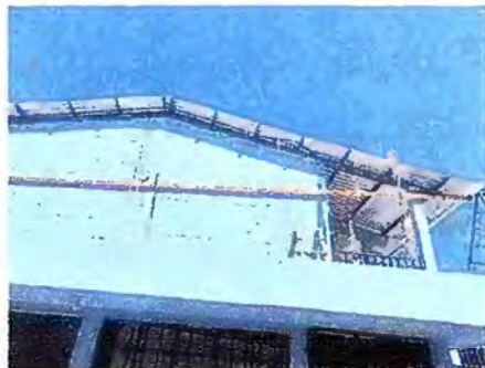
Foto 13 - MODULO 1: Reparación de bajada de agua pluvial, tubo PVC 3"
