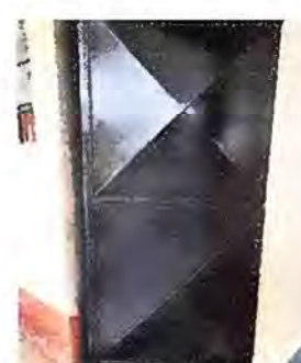
Foto 18 - MODULO 2: Mantenimiento a estructura de puerta
