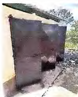
Foto 23 - MODULO 3: Mantenimiento a estructura de puerta
