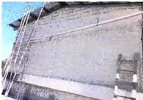
Foto 13 - MODULO 1: Reparación de bajada de agua pluvial, tubo PVC 3"
