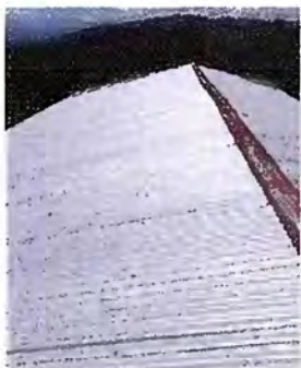
Foto 7 - MODULO 1: Sustrución de lámina, por lámina troquelada aluzinc calibre 26
