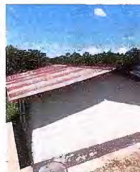
Foto 22 - MODULO 3: Sustitución de elementos de fijación (tornillos)
