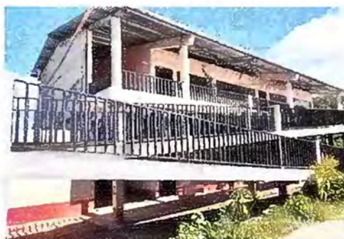
Foto 14 - MODULO 1: Mantenimiento a barandas de metal
