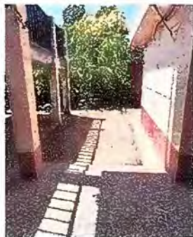
Foto 19 - MODULO 2: Reparación de banquetas de concreto
