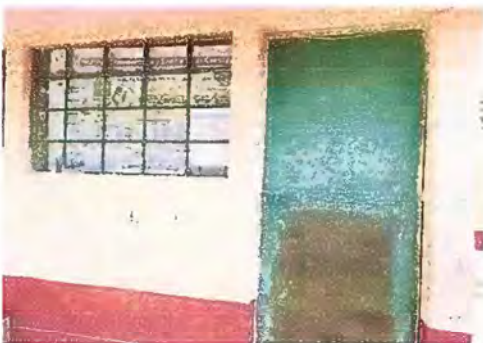
Foto 1 - MODULO 1: Mantenimiento a estructura de puerta
