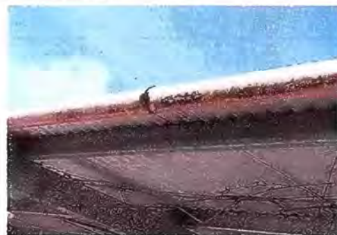
Foto 12 - MODULO 1: Sustrución de soporte o pescante de metal para canal
