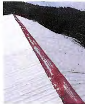
Foto 8 - MODULO 1: Sustrución de capote de lámina para lámina troquelada
