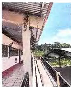
Foto 11 - MODULO 1: Sustrución de canal de pvc
