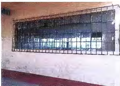
Foto 3 - MODULO 1: Mantenimiento a balcones de metal
