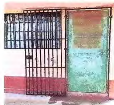
Foto 18 - MODULO 2: Mantenimiento a estructura de puerta
