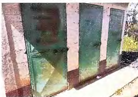
Foto 23 - MODULO 3: Mantenimiento a estructura de puerta
