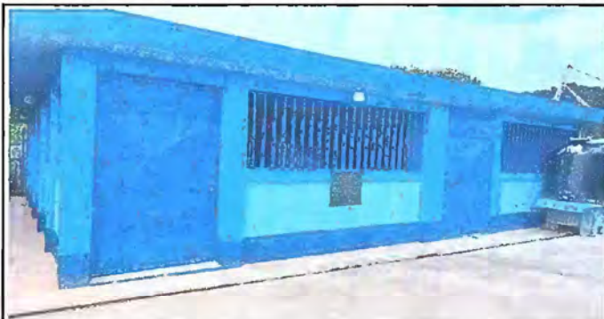
Foto19: MODULO 5 Pintura en muros exteriores e interiores
