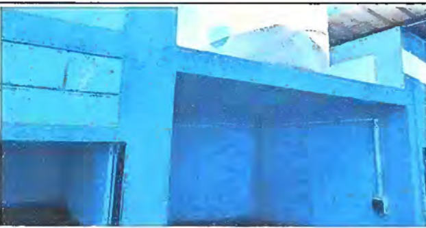
Foto 11: Modulo 2 Pintura en muros exteriores e interiores
