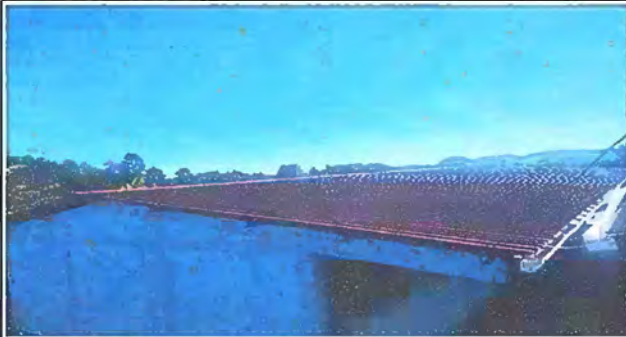
Foto 1: Modulo 1 Sustitución de lámina por lámina troquelada aluzinc calibre 26, Instalación de lámina troquelada aluzinc, Sustitución de elementos de fijacion (tornillos).
