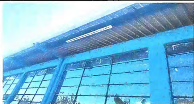
Foto 1: Modulo 1 Sustitución de lamparas tipo LED
