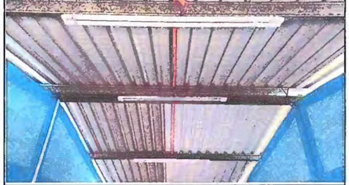
Foto 14: Modulo 3 Sustitución de lamparas tipo LED, Instalación de unidades luz (incluye interruptor, ducto y cable eléctrico)
