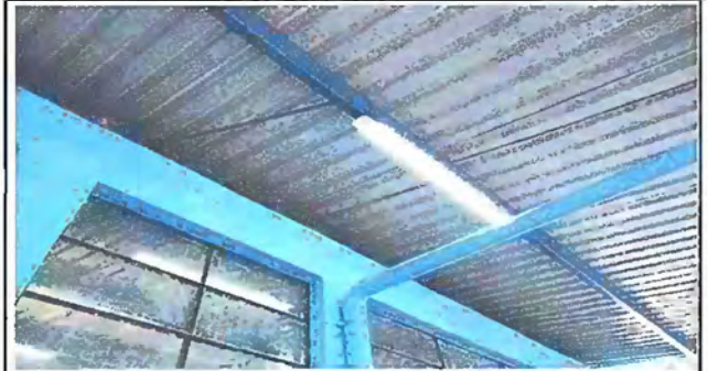
Foto 2: Modulo 1 Sustitución de lamparas tipo LED
