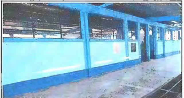
Foto 4: Modulo 1 Pintura en muros exteriores e interiores
