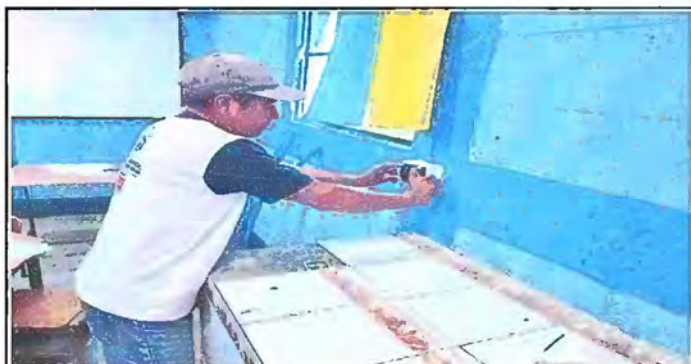
Foto 15: Modulo 3 Sustitución interruptores dobles
