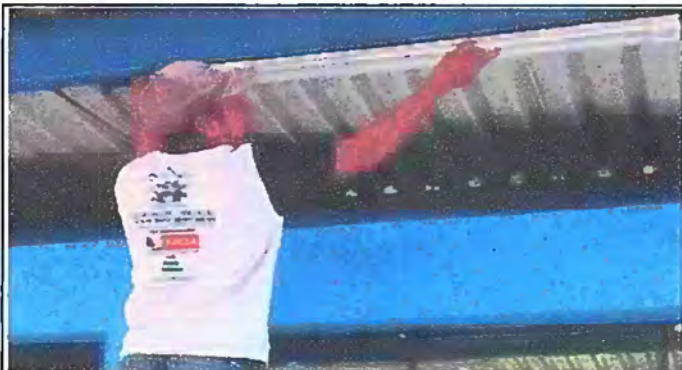
Foto 1: Modulo 1 Sustitución de lamparas tipo LED
