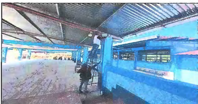
Foto 17: Modulo 4 Sustitución de lamparas tipo LED, Instalación de unidades luz (incluye interruptor, ducto y cable eléctrico)
