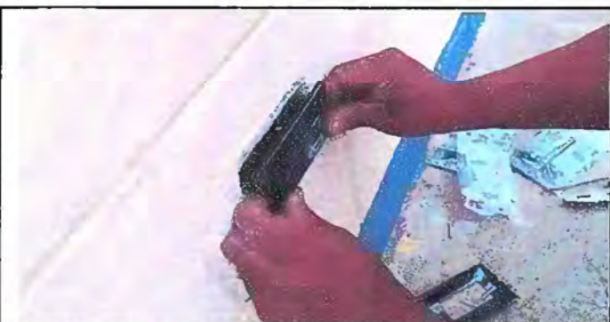
Foto 6: Modulo 1 Sustitución de tomacorrientes dobles
