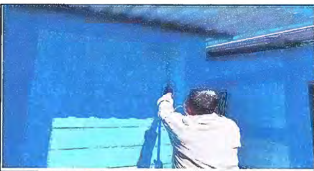
Foto 12: Modulo 3 Pintura en muros exteriores e interiores
