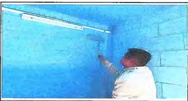
Foto 11: Modulo 2 Pintura en muros exteriores e interiores
