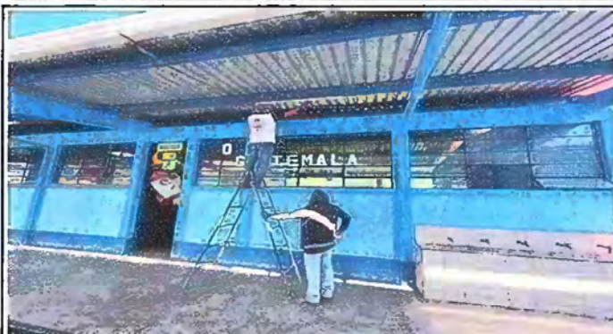
Foto 2: Modulo 1 Sustitución de lamparas tipo LED
