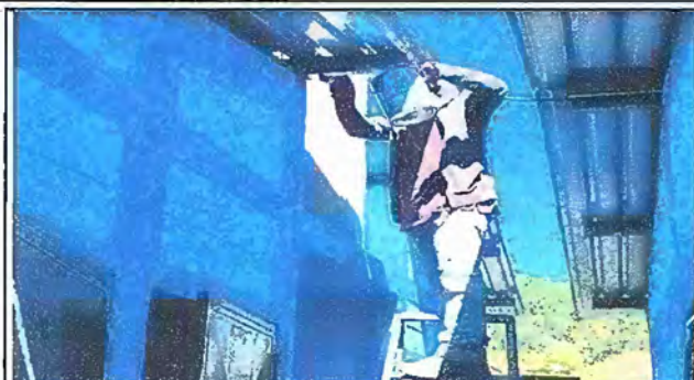
Foto 8: Modulo 2 Mantenimiento a estructura de soporte de metal , Sustitución de elementos de fijacion (tornillos)
