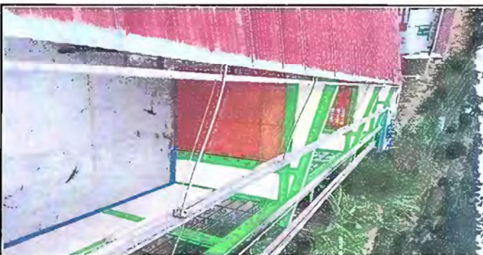
Foto 5: Modulo 1 Sustitución de capote de lámina para lámina troquelada
