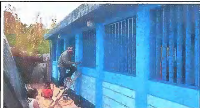
Foto 3: Modulo 5 Mantenimiento a barandas de metal.
