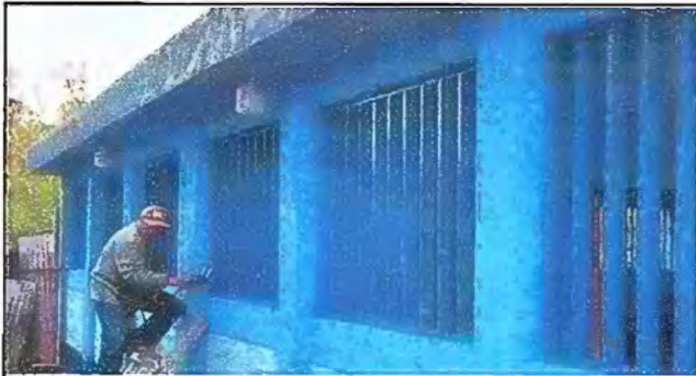
Foto19: MODULO 5 Pintura en muros exteriores e interiores
