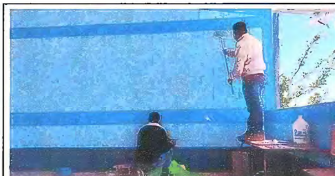
Foto 16: Modulo 4 Pintura en muros exteriores e interiores.
