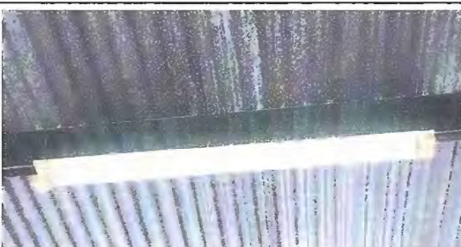
Foto 9: Modulo 2 Sustitución de lamparas tipo LED
