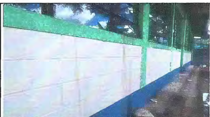
Foto 4: Modulo 1 Pintura en muros exteriores e interiores
