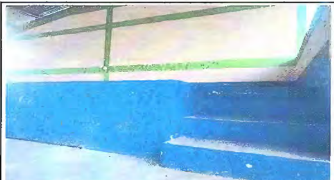
Foto 16: Modulo 4 Pintura en muros exteriores e interiores.
