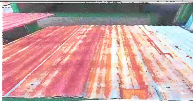
Foto 7: Modulo 2 Sustitución de lámina por lámina troquelada aluzinc calibre 26, Instalación de lámina troquelada aluzinc, Sustitución de elementos de fijación (tornillos).
