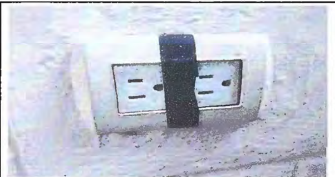
Foto 6: Modulo 1 Sustitución de tomacorrientes dobles
