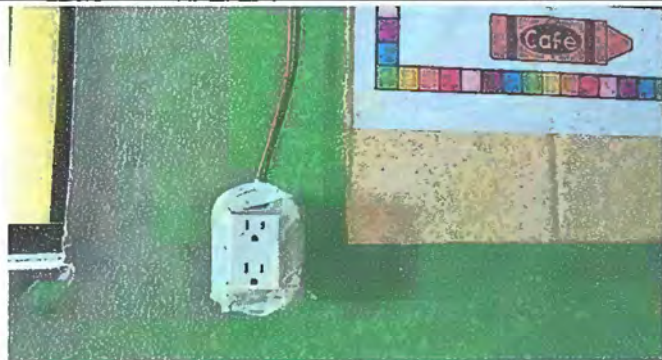
Foto 13: Modulo 3 Sustritucone tomacorrientes dobles, Instalación de unidades fuerza (tomacorriente), incluye cable eléctrico
