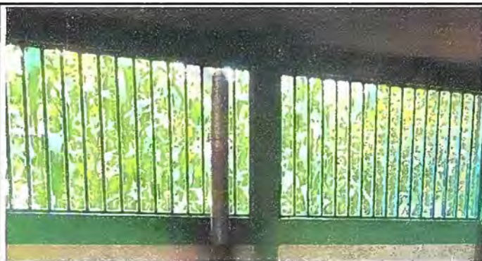
Foto 3: Modulo 5 Mantenimiento a barandas de metal.
