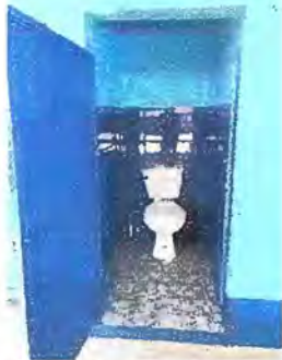
Foto No. 3 Módulo 2 sustitución de inodoro
