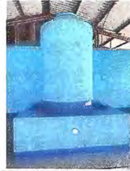
Foto No. 2 Módulo 2 sustitución de azulejo
