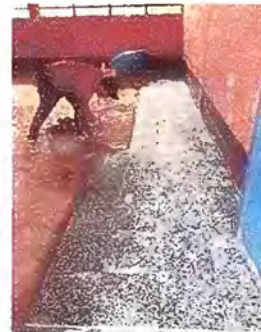
Foto No. 4 Módulo 3 sustitución de piso de cemento por piso de granito
