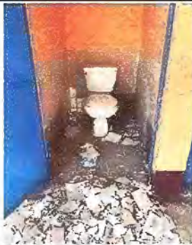
Foto No. 3 Módulo 2 sustitución de inodoro
