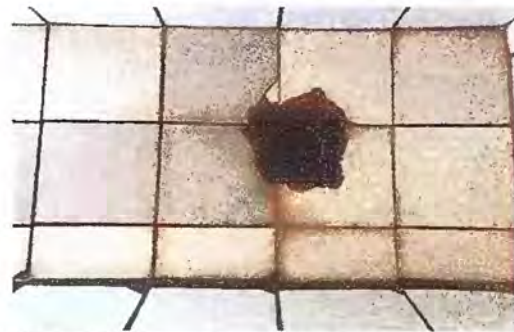
Foto No. 2 Módulo 2 sustitución de azulejo
