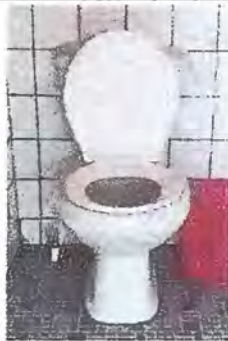
Foto No. 3 Módulo 2 sustitución de inodoro
