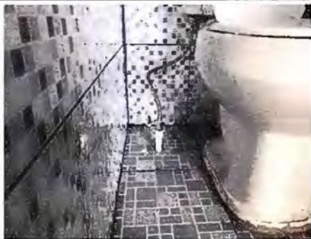
Foto 13 Módulo 3: Sustitución de accesorios inodoro (contra llave, tubo de abasto y tanque)
