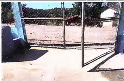
Foto 17 Muros perimetrales: Reparación de tubo hg malla galvanizada
