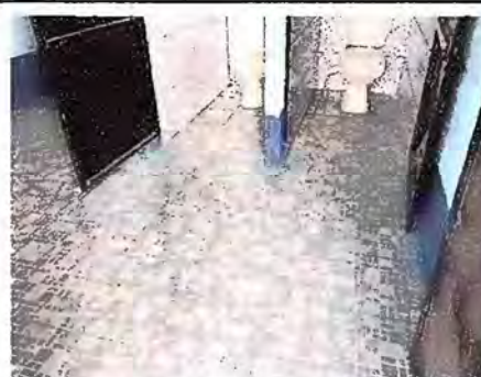
Foto 16 Módulo 3: Sustitución de piso de torta de concreto por piso antideslizante
