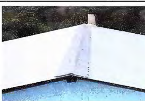
Foto 6 Módulo 1: Sustitución de capote de lámina para lamina troquelada
