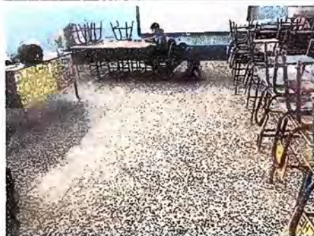
Foto 10 Módulo 2: Sustitución de piso de torta de concreto por piso de granito
