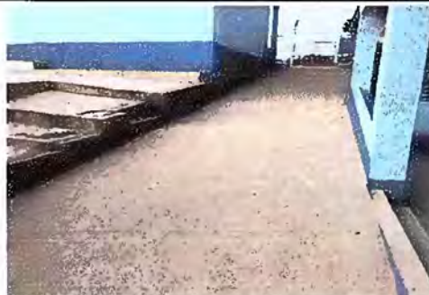
Foto 18 Losa de patio: Reparación de planchas de concreto de patio
