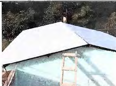
Foto 1 Módulo 1: Sustitución de lámina, por lámina troquelada aluzinc calibre 26
