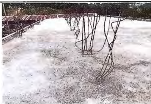
Foto 9 Módulo 2: Impermeabilización de losa
