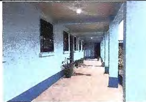
Foto 8 Módulo 2: Sustitución de focos ahorradores
