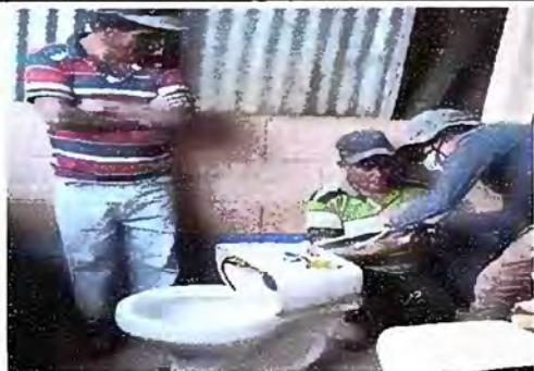
Foto 13 Módulo 3: Sustitución de accesorios inodoro (contra llave, tubo de abasto y tanque)
