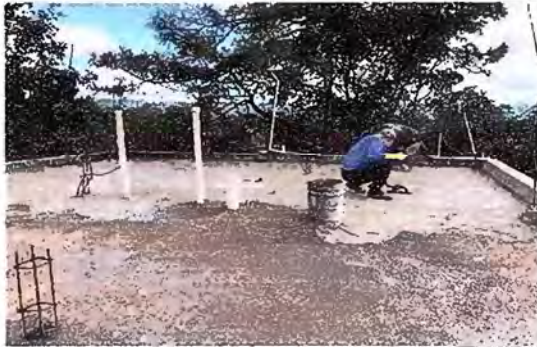
Foto 9 Módulo 2: Impermeabilización de losa
