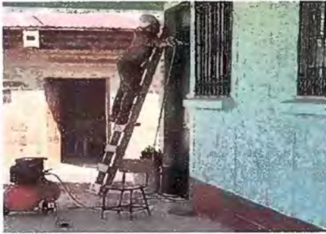
Foto 7 Módulo 2: Mantenimiento a estructura de puerta (lijado, aplicación de pintura)
