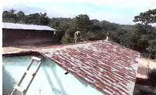
Foto 2 Módulo 1: Sustitución de elementos de fijación (tornillos)
