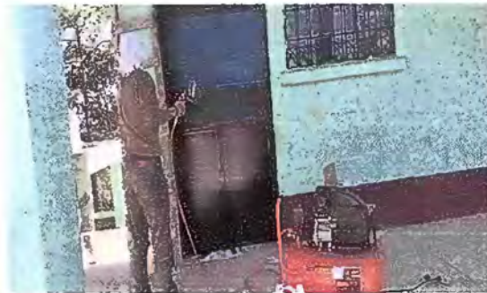
Foto 11 Módulo 3: Mantenimiento a estructura de puerta (lijado, aplicación de pintura)
