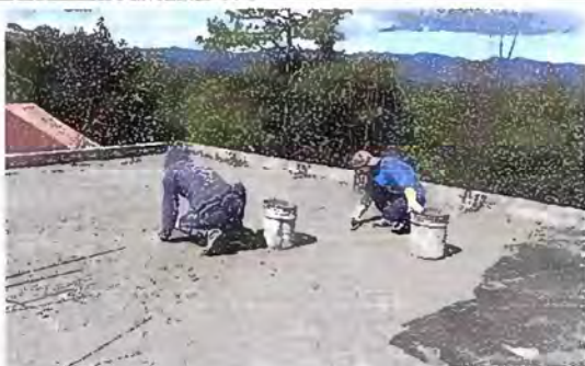
Foto 15 Módulo 3: Impermeabilización de loza
