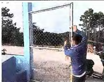
Foto 17 Muros perimetrales: Reparación de tubo hg malla galvanizada
