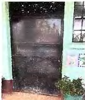
Foto 7 Módulo 2: Mantenimiento a estructura de puerta (lijado, aplicación de pintura)
