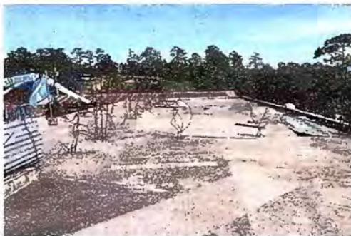
Foto 9 Módulo 2: Impermeabilización de losa
