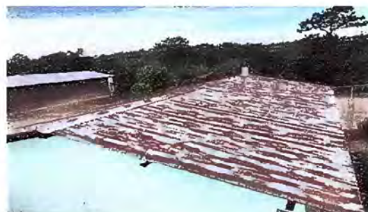
Foto 2 Módulo 1: Sustitución de elementos de fijación (tornillos)
