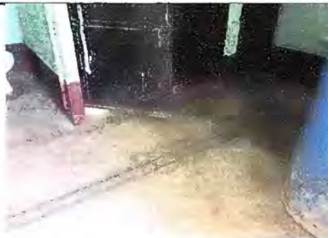
Foto 16 Módulo 3: Sustrución de piso de torta de concreto por piso antideslizante
