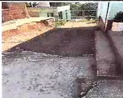
Foto 18 Losa de patio: Reparación de planchas de concreto de patio
