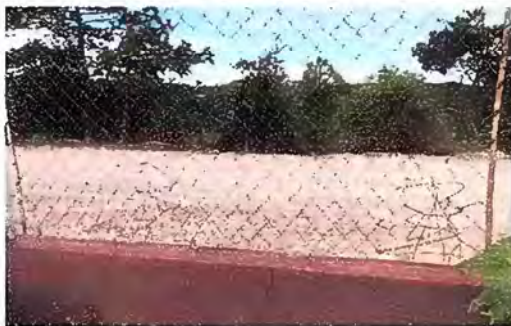
Foto 17 Muros perimetrales: Reparación de tubo hg malla galvanizada
