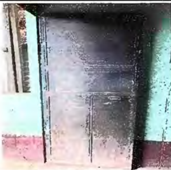
Foto 11 Módulo 3: Mantenimiento a estructura de puerta (lijado, aplicación de pintura)
