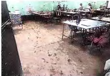
Foto 10 Módulo 2: Sustitución de piso de torta de concreto por piso de granito
