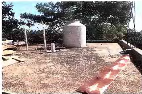
Foto 15 Módulo 3: Impermeabilización de loza
