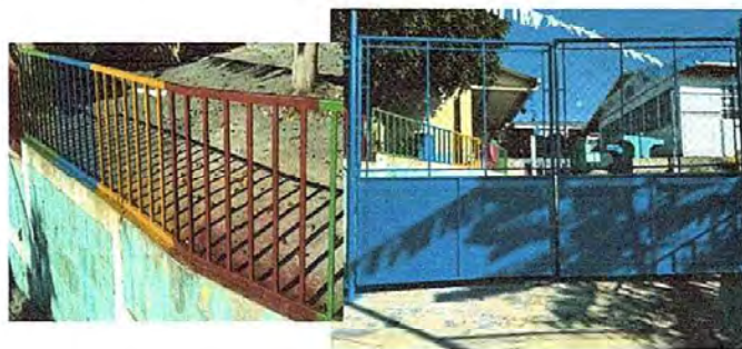
Foto 11: Area exterior mantenimiento de barandas y portones
