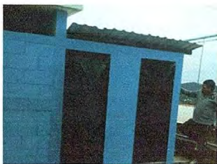
Foto 9: Modulo 10. Mantenimiento de puertas
