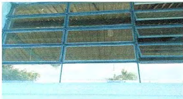
Foto 1: Módulo 1. Mantenimiento de estructura metal, sustitución de vidrios
