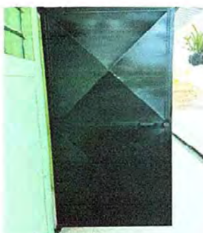
Foto 3: Módulo 2 Mantenimiento de puertas
