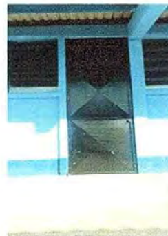
Foto 2: Módulo 1 Mantenimiento de puestas
