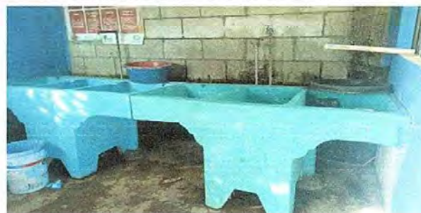
Foto 12: Area Exterior Sustitución de pilas
