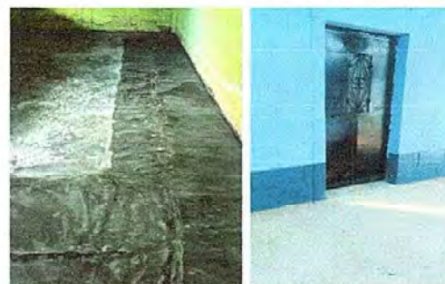
Foto 4: Módulo 3 sustitución piso de concreto, Mantenimiento de puertas
