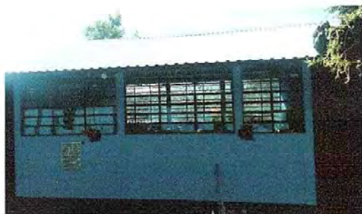
Foto 5: Módulo 4 Sustitución de lamina por lámina troquelada, sustitución de lemeneos de fijación
