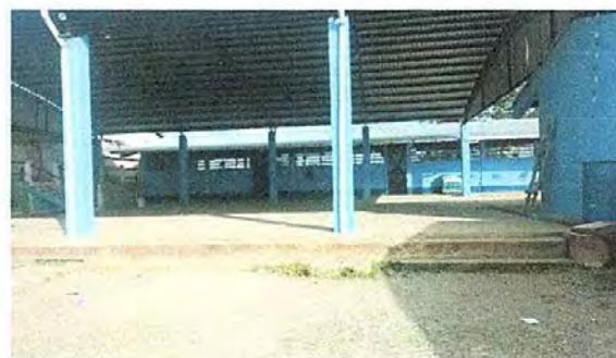
Foto 10: pintado de exteriores e interiores
