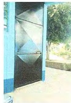
Foto 8: Modulo 8. Mantenimiento de puertas
