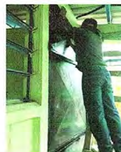
Foto 8: Modulo 8. Mantenimiento de puertas
