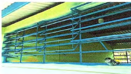
Foto1: Módulo 1 Mantenimiento de estructura metal, sustitución de vidrios
