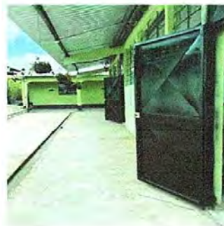
Foto 2: Módulo 1 Mantenimiento de puertas
