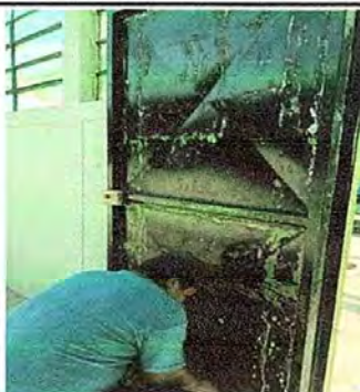
Foto 9: Modulo 10. Mantenimiento de puertas
