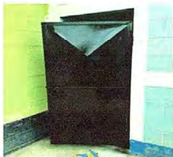
Foto 3: Módulo 2 Mantenimiento de puertas
