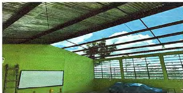
Foto 5: Módulo 4 Sustitución de lamina por lámina troquelada, sustitución de lemeneos de fijación
