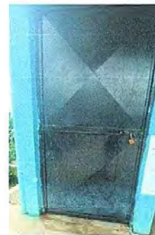
Foto 8: Modulo 8. Mantenimiento de puertas
