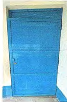
Foto 7: Modulo 5 Mantenimiento de puertas
