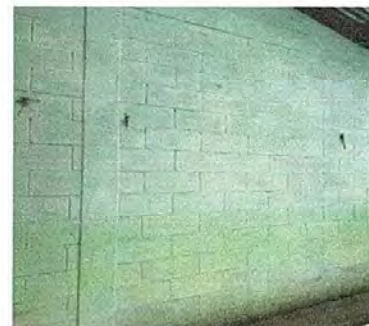
Foto 10: pintado de exteriores e interiores
