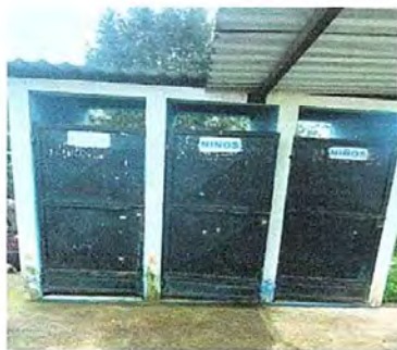
Foto 9: Modulo 10. Mantenimiento de puertas
