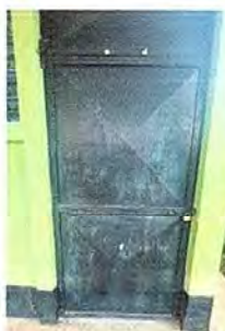
Foto 3: Módulo 2 Mantenimiento de puertas
