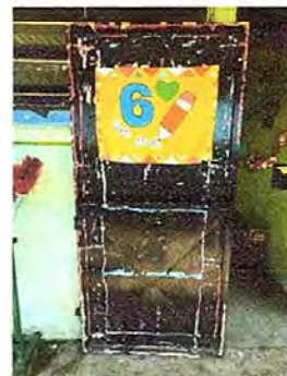
Foto 2: Módulo 1 Mantenimiento de puertas
