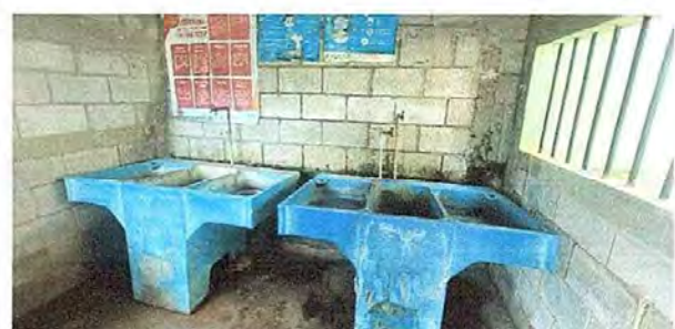
Foto 12: Area Exterior Sustitución de pilas
