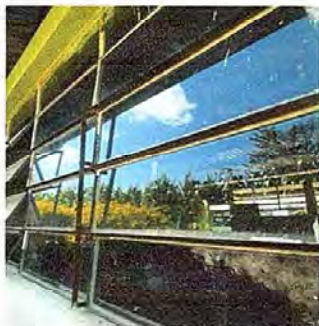
Foto1: Módulo 1 Mantenimiento de estructura metal, sustitución de vidrios
