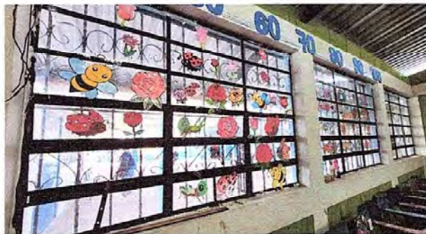
Foto 7: Módulo 2. Sustitución de vidrios.
