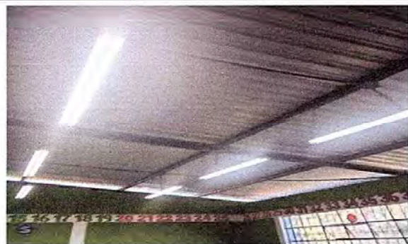
Foto 3: Módulo 1. Sustitución de lámparas led.
