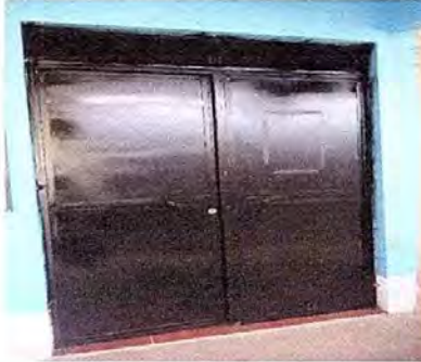
Foto 8: Módulo 2. Mantenimiento a estructura de puerta (lijado y tintura).
