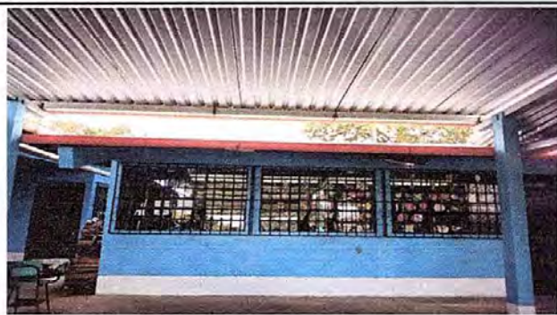
Foto 9: Módulo 2. Reparación de bajada de agua pluvial.
