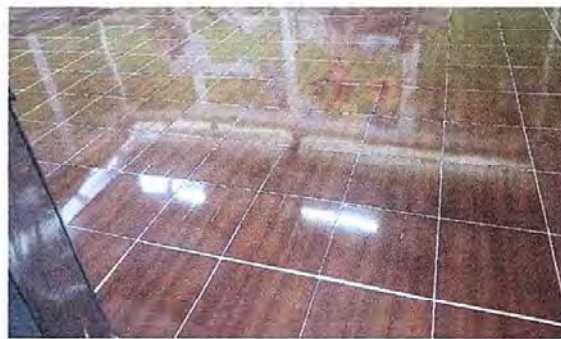
Foto 10: Módulo 2. Sustitución de torta de cemento a piso cerámico.
