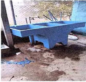
Foto 13: Módulo 3. Sustitución de pila para lavar.
