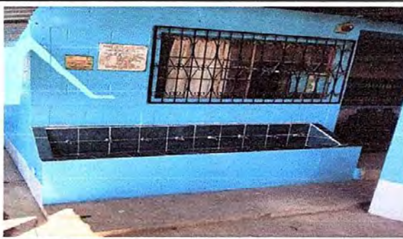
Foto 12: Módulo 3. Sustitución de azulejos en lavamanos.
