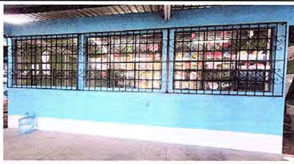
Foto 6: Módulo 2. Suministro e instalación de balcones de hierro en ventanas.
