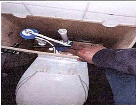
Foto 11: Módulo 3. Sustitución accesorios de inodoros.
