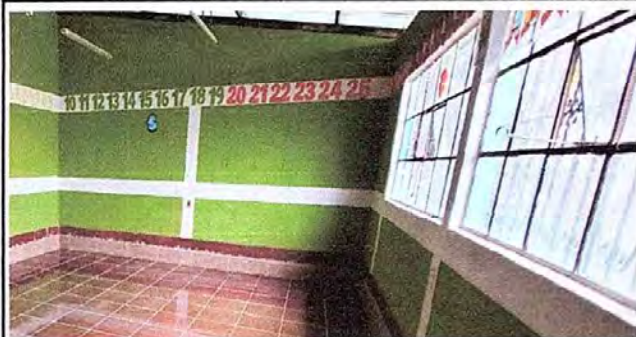
Foto1: Módulo 1. Sustitución de vidrios.
