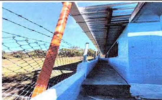
Foto 5: Módulo 1. Reparación de bajada de agua pluvial, tubo pvc.
