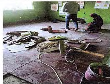
Foto 2: Módulo 1. Sustitución de torta de cemento a piso cerámico.
