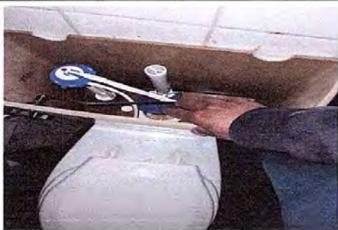
Foto 11: Módulo 3. Sustitución accesorios de inodoros.
