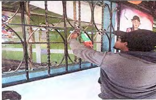
Foto1: Módulo 1. Sustitución de vidrios.
