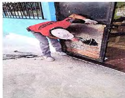
Foto 8: Módulo 2. Mantenimiento a estructura de puerta (lijado y pintura).
