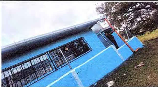
Foto 5: Módulo 1. Reparación de bajada de agua pluvial, tubo pvc.
