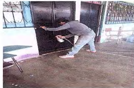
Foto 4: Módulo 1. Mantenimiento a estructura de puerta (lijado y pintura).
