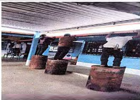
Foto 9: Módulo 2. Reparación de bajada de agua pluvial.
