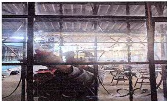
Foto 7: Módulo 2. Sustitución de vidrios.
