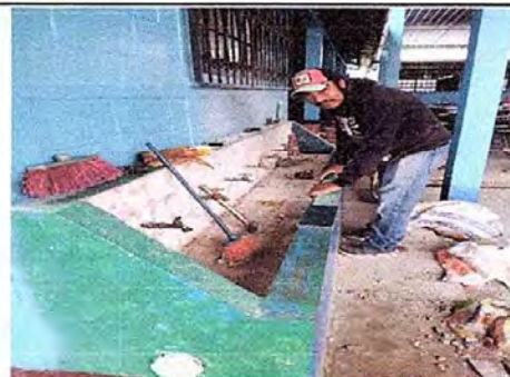
Foto 12: Módulo 3. Sustitución de azulejos en lavamanos.
