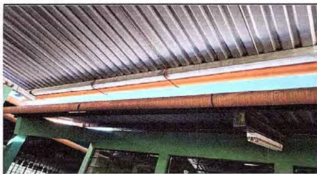
Foto 9: Módulo 2. Reparación de bajada de agua pluvial.
