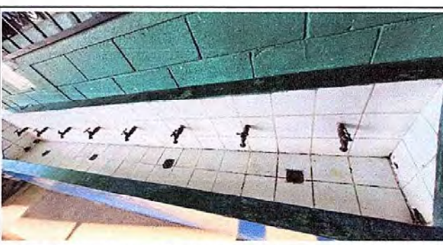
Foto 12: Módulo 3. Sustitución de azulejos en lavamanos.
