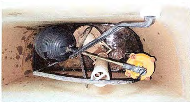
Foto 11: Módulo 3. Sustitución accesorios de inodoros.
