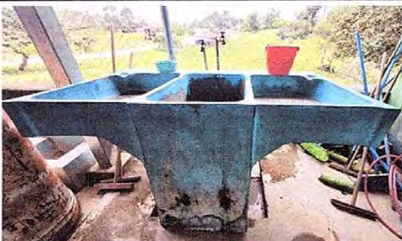
Foto 13: Módulo 3. Sustitución de pila para lavar.
