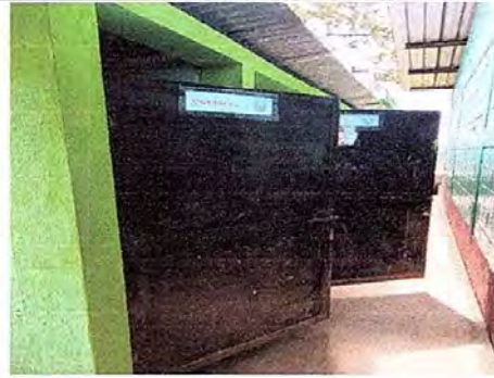
Foto 14: Módulo 3. Mantenimiento a estructura de puerta (lijado y pintura).
