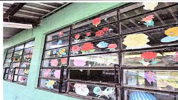
Foto 7: Módulo 2. Sustitución de vidrios.
