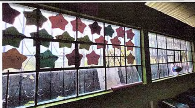
Foto 1: Módulo 1. Sustitución de vidrios.
