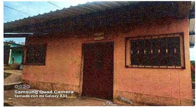
Foto 8: MODULO 1: Instalacion de lámina troquelada aluzinc calibre 26
