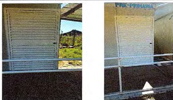
Foto 18: MODULO 4:Mantenimiento a estructura de puerta (lijado, cambio de tubo, cepillado, aplicación de pintura)
