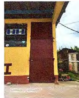
Foto 12: MODULO 2: Mantenimiento a estructura de puerta (lijado, cambio de tubo, cepillado, sujeciones, aplicación de pintura)
