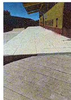
Foto 10: MODULO 2: Sustitucion de piso de torta de concreto por piso cerámico
