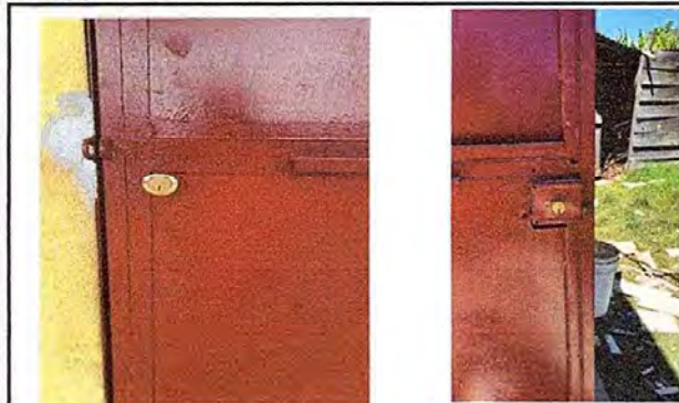
Foto 14: MODULO 2: Sustitución de chapa
