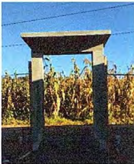
Foto 3: MURO PERIMETRAL: Reparación de columna de puerta de metal
