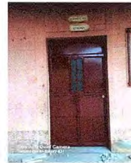
Foto 6: MODULO 1 :Mantenimiento a estructura de puerta (lijado, cambio de tubo, cepillado, sujeciones, aplicación de pintura)
