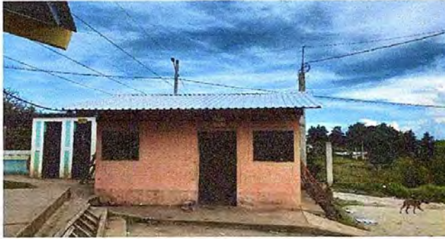
Foto 7: MODULO 1: Sustitución de lámina por lámina troquelada aluzinc calibre 26
