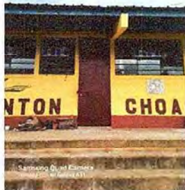
Foto 11: MODULO 2: Mantenimiento a estructura de puerta (lijado, cambio de tubo, cepillado, aplicación de pintura)
