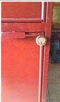
Foto 5: MODULO 1: Sustitución de chapa
