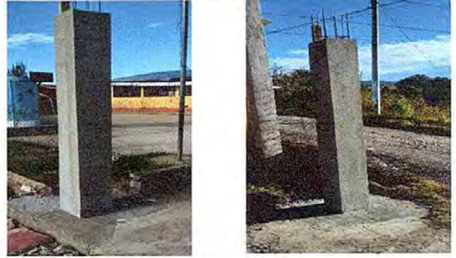
Foto 2: MURO PERIMETRAL. Reparación de columna de porton de metal
