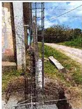
Foto 3: MURO PERIMETRAL Reparación de columna de porton de metal
