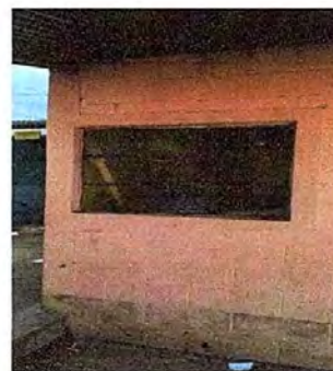
Foto 10: MODULO 1: Suministro e instalación de balcones de metal de 0.90 x 1.12
