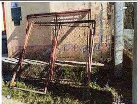
Foto 1: MURO PERIMETRAL Sustrucción de porton de metal de 5.30 x 2.40 mts.
