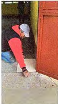
Foto 11: MODULO 2: Sustitución de piso de torta de concreto por piso cerámico
