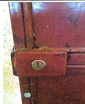
Foto 14: MODULO 2: Sustitución de chapa
