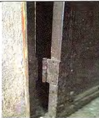
Foto 7: MODULO 1 :Mantenimiento a estructura de puerta (lijado, cambio de tubo, cepillado, sujeciones, aplicación de pintura)
