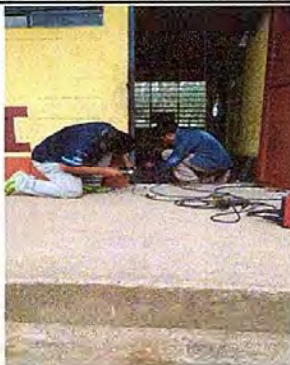
Foto 13: MODULO 2 :Mantenimiento a estructura de puerta (lijado, cambio de tubo, cepillado, sujeciones, aplicación de pintura)
