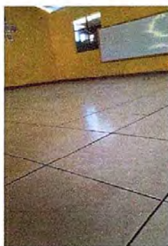
Foto 15: MODULO 3 Sustitucion de piso de torta de concreto por piso cerámico
