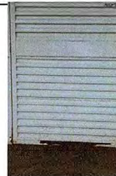
Foto 18: MODULO 4:Mantenimiento a estructura de puerta (lijado, cambio de tubo, cepillado, aplicación de pintura)
