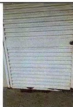
Foto 18: MODULO 4:Mantenimiento a estructura de puerta (lijado, cambio de tubo, cepillado, aplicación de pintura)
