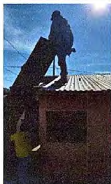
Foto 9: MODULO 1: Instalación de lámina troquelada aluzinc calibre 26
