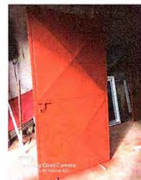
Foto 16: MODULO 3: Mantenimiento a estructura de puerta (lijado, cambio de tubo, cepillado, aplicación de pintura)
