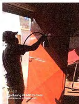
Foto 16: MODULO 3: Mantenimiento a estructura de puerta (lijado, cambio de tubo, cepillado, aplicación de pintura)
