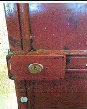
Foto 17: MODULO 3:Sustitución de chapa
