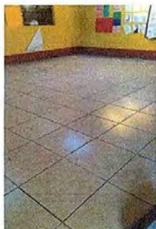
Foto 15: MODULO 3 Sustitucion de piso de torta de concreto por piso cerámico
