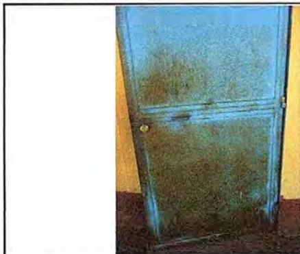
Foto 13: MODULO 2 :Mantenimiento a estructura de puerta (lijado, cambio de tubo, cepillado, sujeciones, aplicación de pintura)
