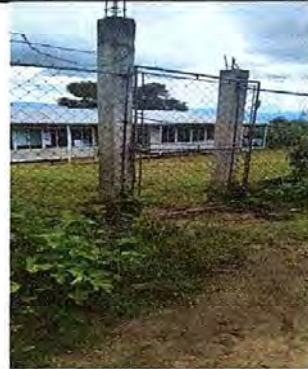
Foto 2: MURO PERIMETRAL Sustrucción de puerta de metal 1.00 X 1.90 mts
