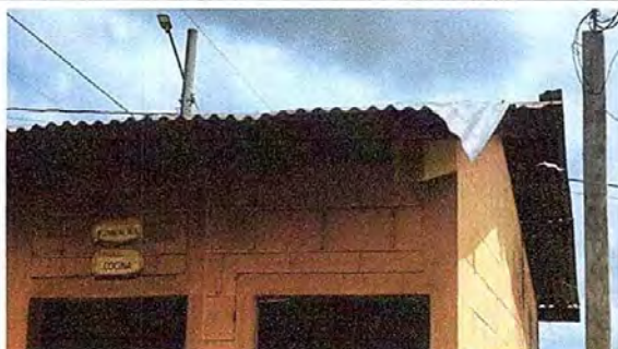
Foto 9: MODULO 1: Instalación de lámina troquelada aluzinc calibre 26
