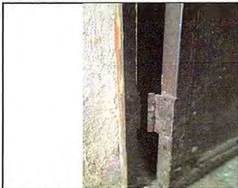
Foto 7: MODULO 1: Mantenimiento a estructura de puerta (lijado, cambio de tubo, cepillado, sujeciones, aplicación de pintura)
