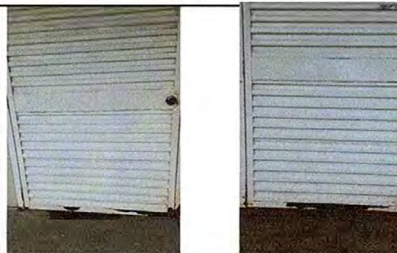
Foto 18: MODULO 4:Mantenimiento a estructura de puerta (lijado, cambio de tubo, cepillado, aplicación de pintura)
