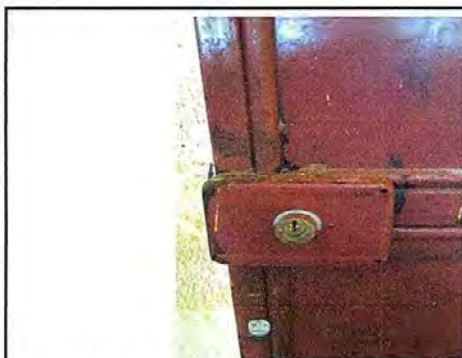
Foto 17: MODULO 3:Sustitución de chapa
