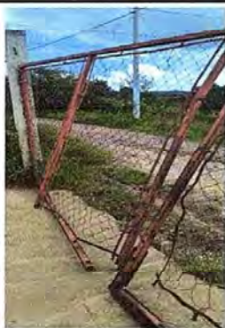
Foto 1: MURO PERIMETRAL Sustrucción de porton de metal de 5.30 x 2.40 mts.
