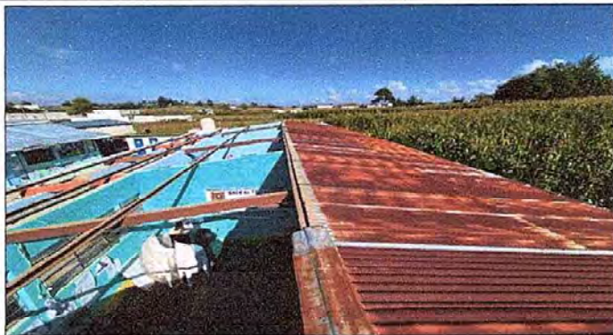
Foto 2: MODULO 1. Sustitución de estructura portante de metal por metal.
